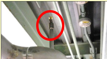
スプリンクラーの設置 (約1600箇所/2基)
