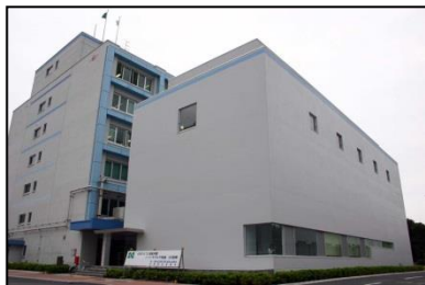
緊急時対策所(東海第二)
