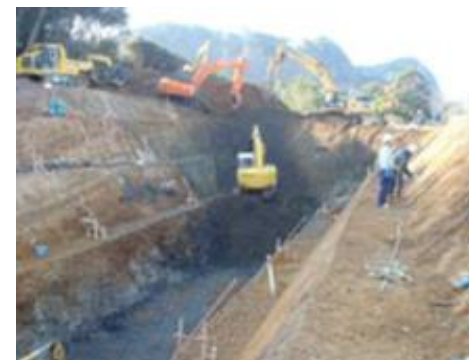
トレンチ調査
