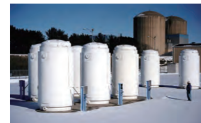
▲プレーリー・アイランド原子力発電所(アメリカ)
