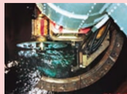
原子炉の解体
