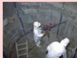
原子炉の周囲にある施設の解体
