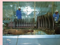
周辺設備の解体
