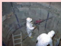
原子炉の周囲にある施設の解体
