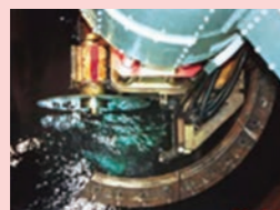
原子炉の解体
