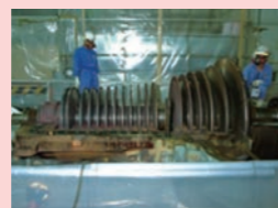
周辺設備の解体
