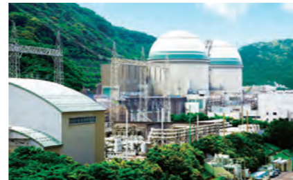
プルサーマルを導入した高浜発電所3,4号機 写真提供:関西電力株式会社
