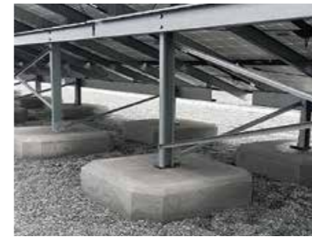
コンクリート内への固定 (CO 2 -SUICOM) 提供: 中国電力株式会社
