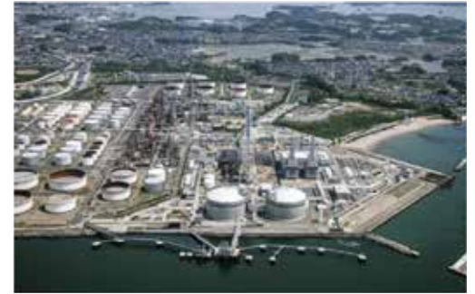
新仙台火力発電所 提供：東北電力株式会社
