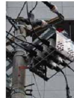
絶縁カバー設置状態
