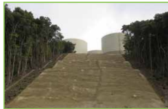
防火帯（モルタル吹き付け状態） 写真提供:関西電力(株)
