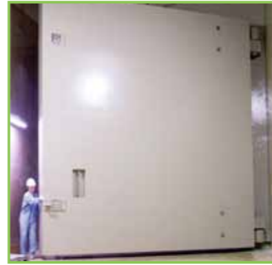
水密扉の設置 写真提供:中部電力(株)
