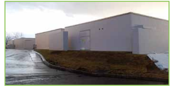
緊急時対策所(外観) 写真提供:北海道電力(株)
