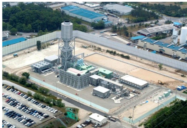
東北電力・東新潟発電所5号機(2012年6月営業運転開始)
