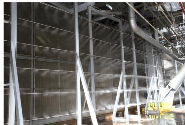
中部電力・新名古屋発電所8号系列
