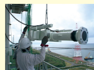
制震装置の取り付け
