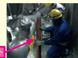
配管サポートの強化
