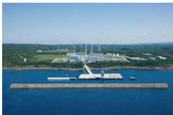
環境に配慮した発電所の建設
