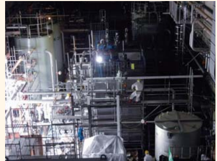
循環注水冷却の要となる汚染水の浄化設備
