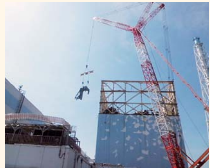
福島第一原子力発電所1号機 原子炉建屋カバー鉄骨建方の作業状況
