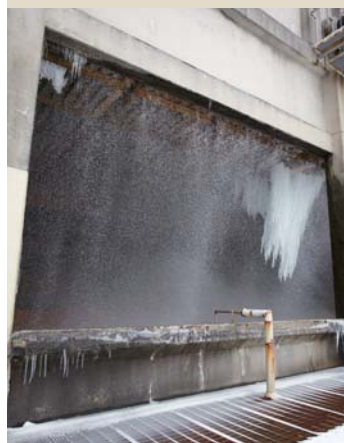
発電に利用した蒸気を冷却するための循環水を外気で冷やす冷却塔。冬場には大きなつららもできる
