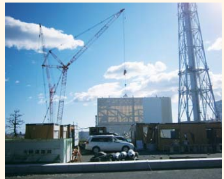
原子炉建屋上部の測定の様子
