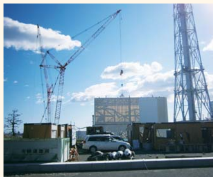
原子炉建屋上部の測定の様子
