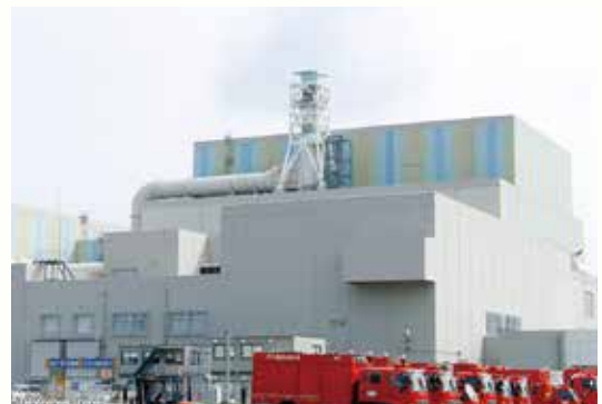
島根原子力発電所3号機外観
