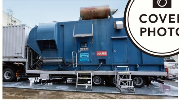
恒設空冷式非常用発電装置で電源を多重化
