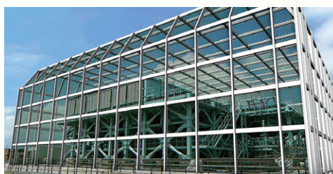
写真1: 設計基準の安全性向上工事例(竜巻対策)
