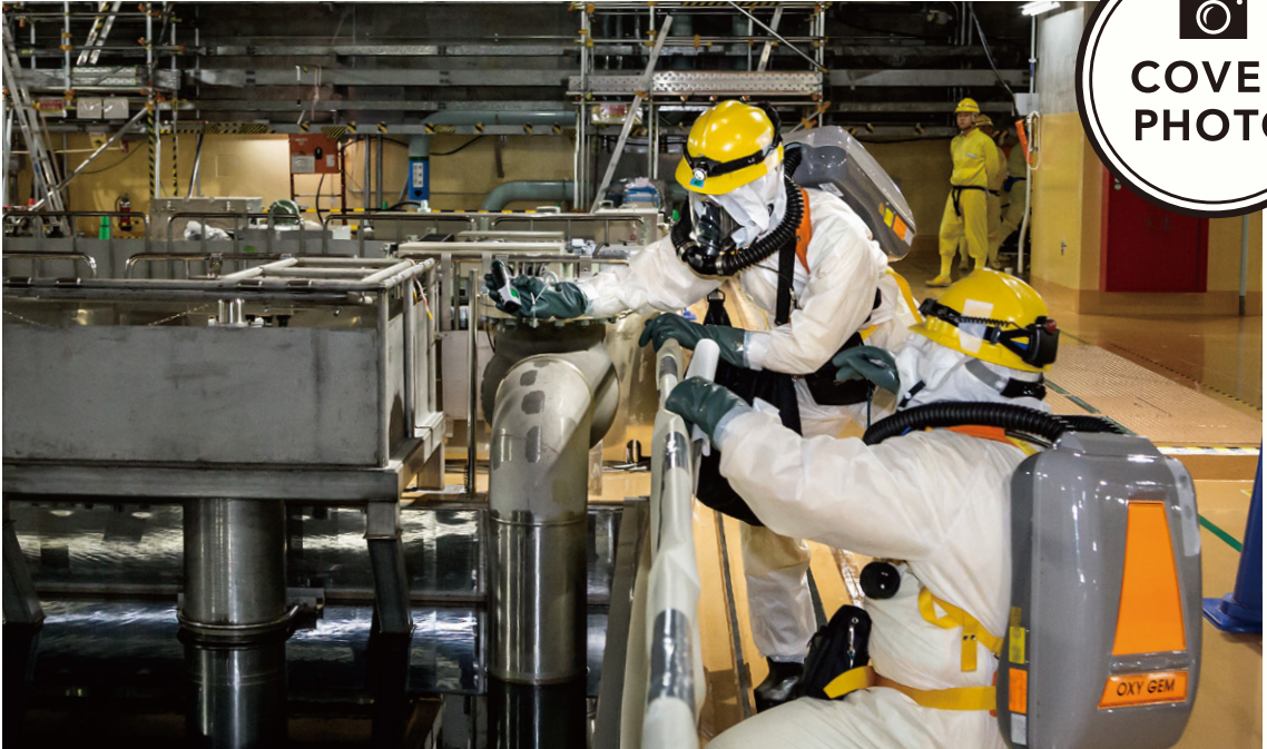
使用済燃料貯蔵プールの水位や放射線量を手順に沿って確認
