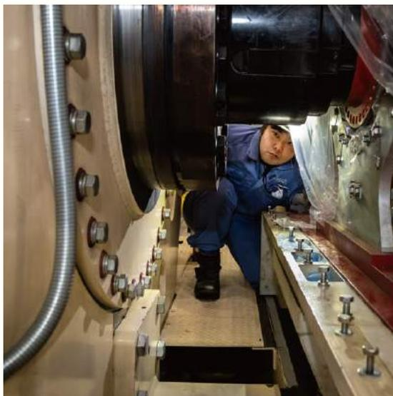
発電機軸受部分の点検の様子
