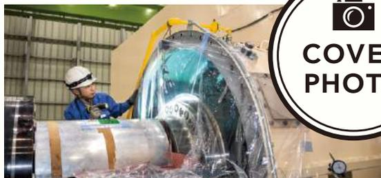
蒸気タービンと発電機の結合部を目視で点検
