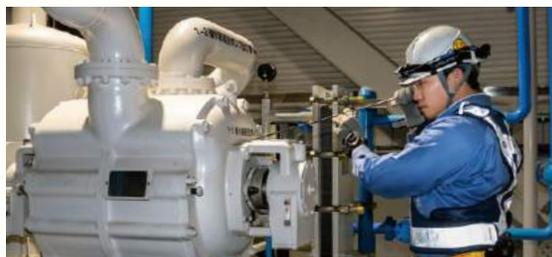
ポンプの水の流れを聴診棒で確認
