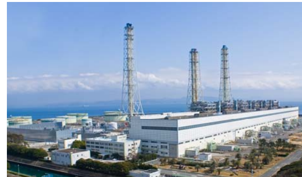
東京電力・横須賀火力発電所(2011年4月から順次再稼働)
