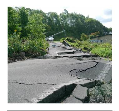
地震の影響で道路が陥没し、被害を受けた配電設備 を復旧することが難しい状態(厚真町)
