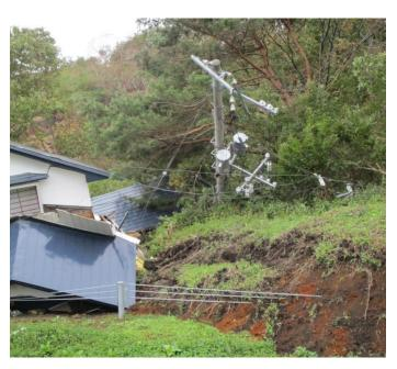
山の斜面の地崩れにより、配電設備が押し流され、 土の中に埋まっている状態(厚真町)
