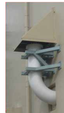
給排気口の改造
