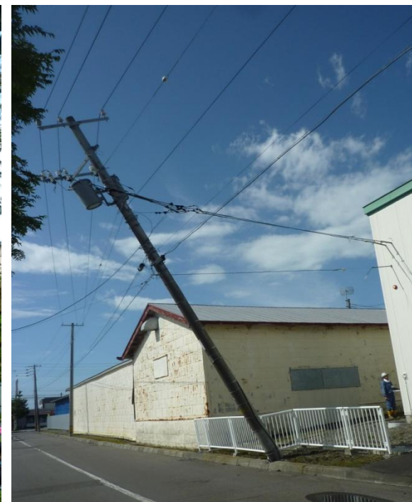
電柱折損・傾斜現場 (沙流郡日高町)
