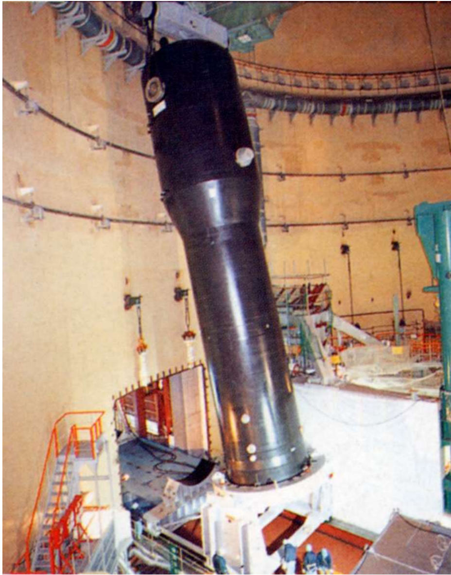
蒸気発生器取替
