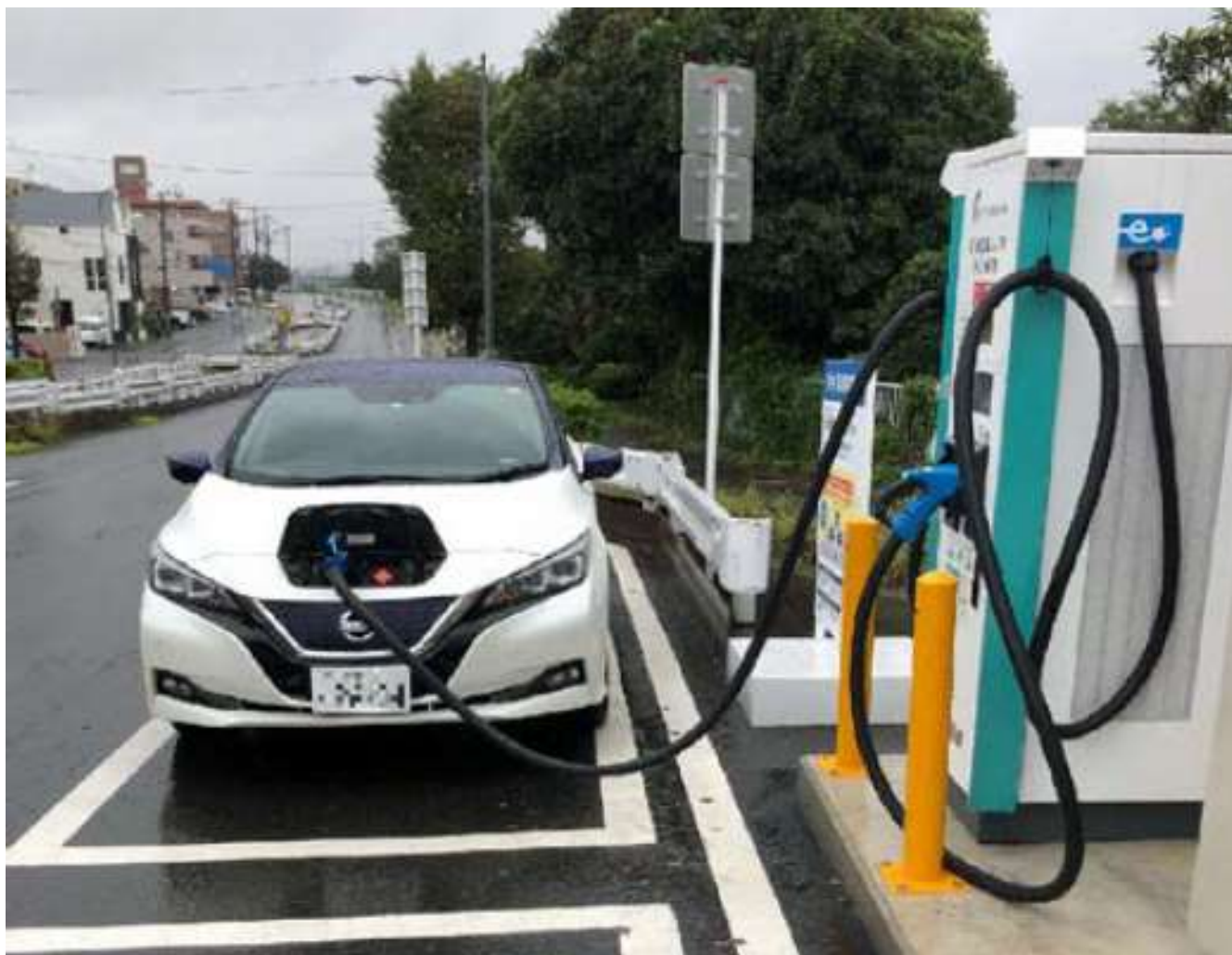
公道に設置された充電器（出典：e-Mobility Power プレスリリース資料）
