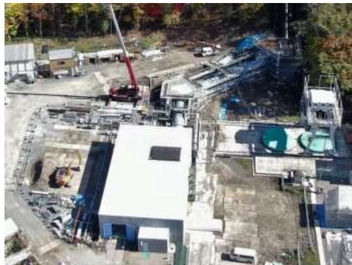
発電所建設状況
