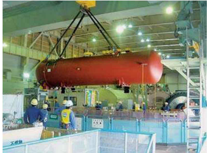
高圧給水加熱器取替
