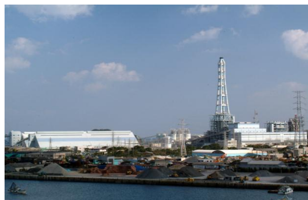
九州電力・荻田発電所新2号機(2012年6月から再稼働)
