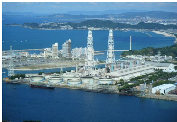
関西電力・海南発電所2号機(2012年7月から再稼働)
