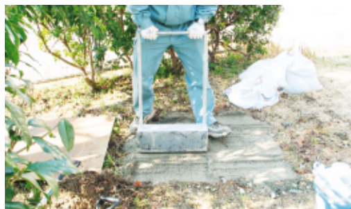
④ 下地転圧
