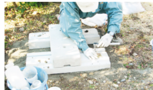
⑨ アンカー設置
