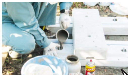
⑩ 無収縮モルタル流込み
