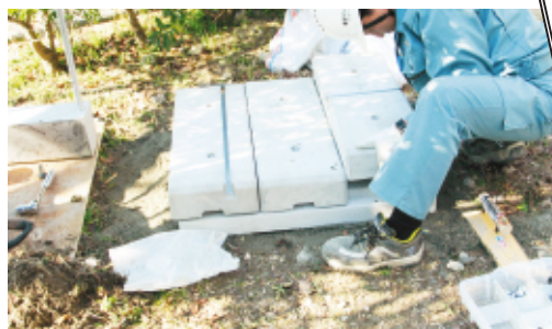
⑪ 上部ブロック設置
