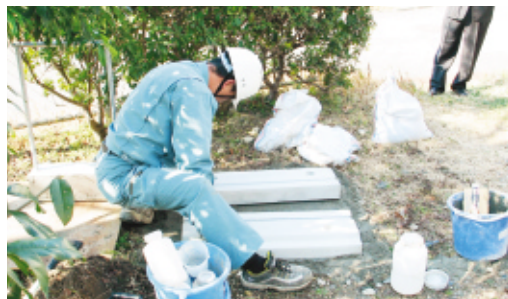
⑦ 下部ブロック設置
