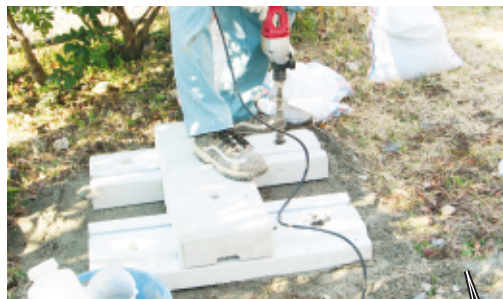
⑧ アンカー用ドリル削孔
