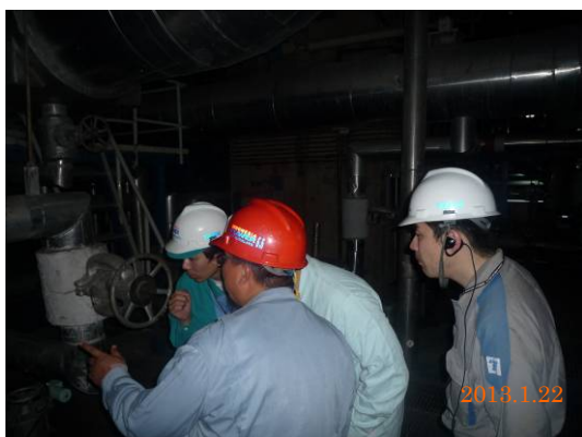
現場を確認しながらのディスカッション （スララヤ火力発電所）
