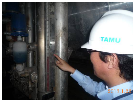
現場設備の水位計確認状況 （スララヤ火力発電所）
