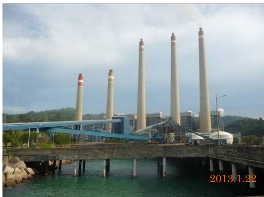
スララヤ火力発電所（全景）
