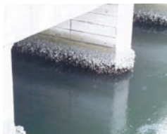
発電所の冷却水取水路に付着したムラサキイガイなどの貝類
