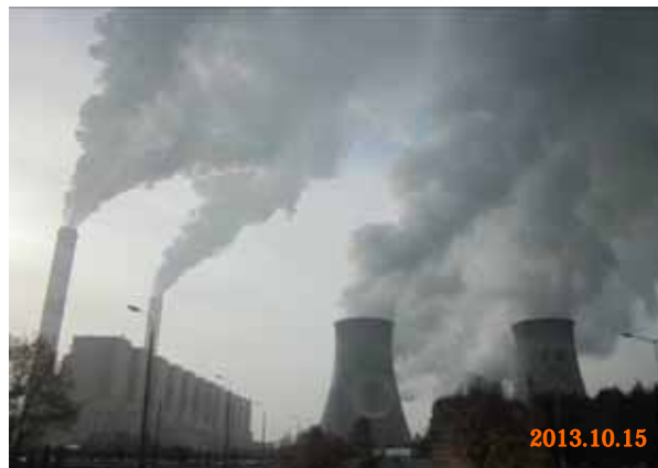
ベウハトゥフ発電所全景
