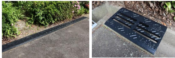
浜岡原子力発電所における側溝用蓋の設置状況 （写真は中部電力より提供）
