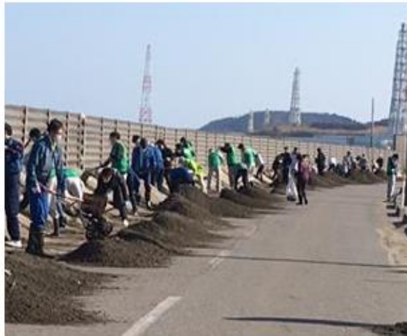
発電所敷地近傍の道路の車道およびフェンス際に堆積した砂の撤去作業
