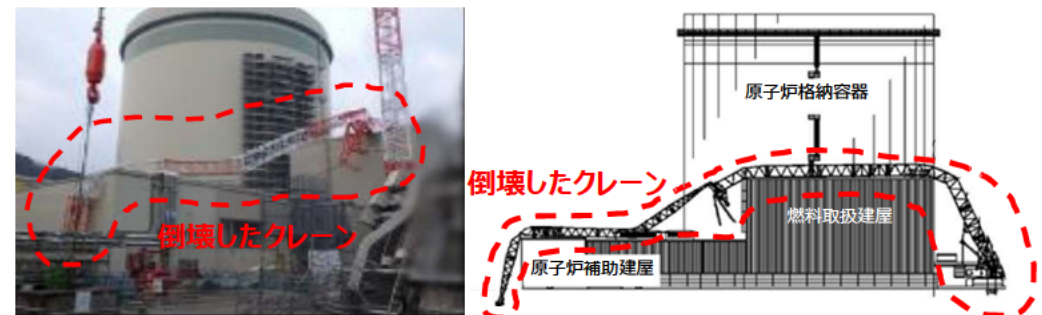
原子炉補助建屋および燃料取扱建屋
