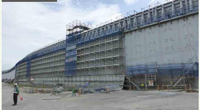
海拔22メートル防波壁 (浜岡原子力発電所)
