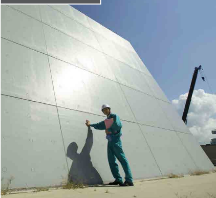
海拔15メートル防波壁 (島根原子力発電所)
