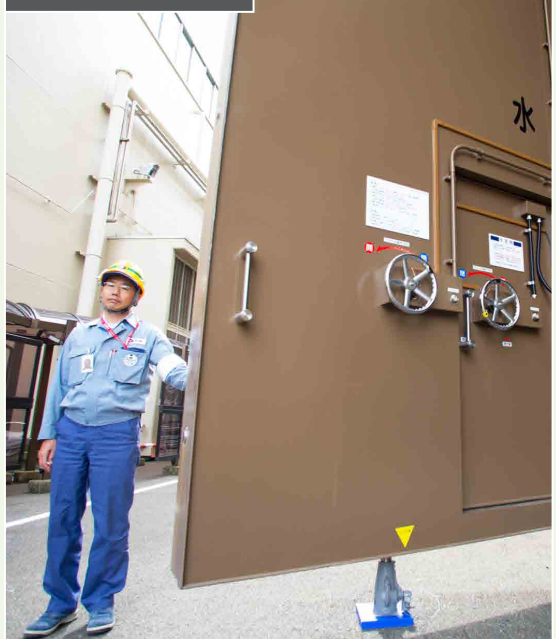
3号機原子炉建屋、制御建屋 (大飯発電所)
