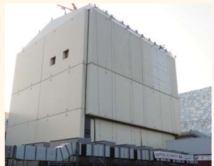
1号機原子炉建屋カバー屋根パネル設置完了
