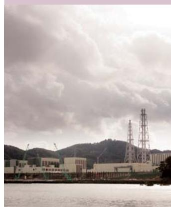
東日本大震災をもたらした東北地方太平洋沖地震。震源地に最も近い原子力発電所が東北電力女川原子力発電所(宮城県女川町、石巻市)です。今から3年前の2011年3月11日、地震動を感知した安全装置が設計どおり作動し、原子炉は自動停止しました。ほどなく未曾有の大津波が幾度も押し寄せ、その最高水位は13mにも達しました。しかし、同発電所では建設段階から津波対策が重要課題であると認識し、敷地高さを海拔14.8mに設計していました。また、営業運転開始後も、様々な地震・津波対策を積み重ねてきた結果、原子炉等を冷やし続ける機能が失われることなく、発電所の「安全」が確保されました。
