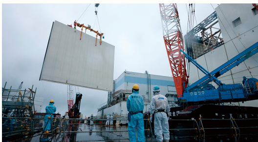
1号機建屋カバーの取り外しが完了
