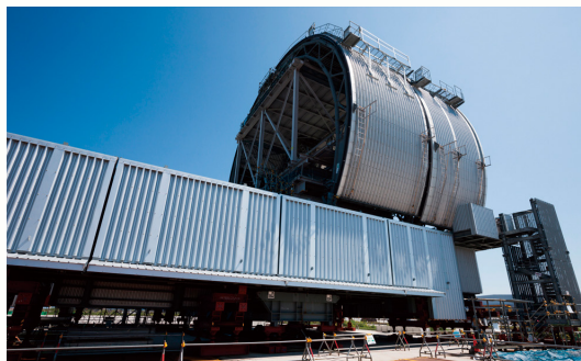
3号機に取り付けられる予定の燃料取り出し用カバー
