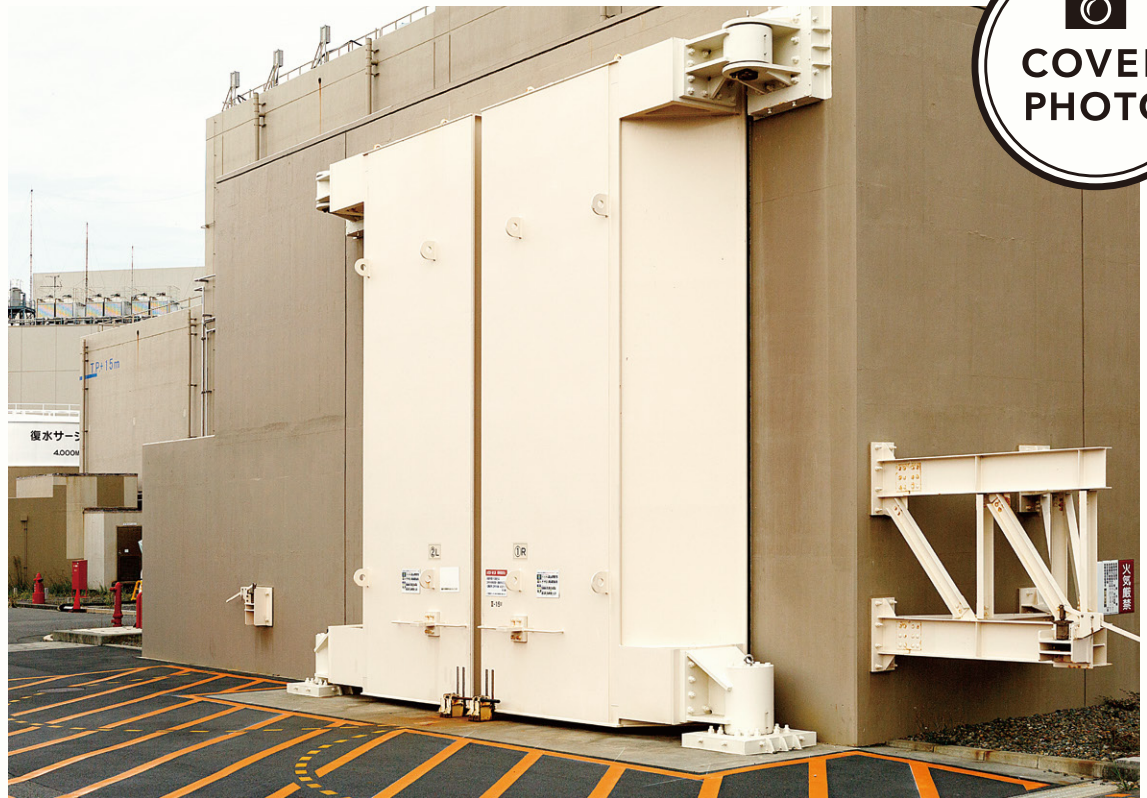
中部電力浜岡原子力発電所3号機の強化扉
