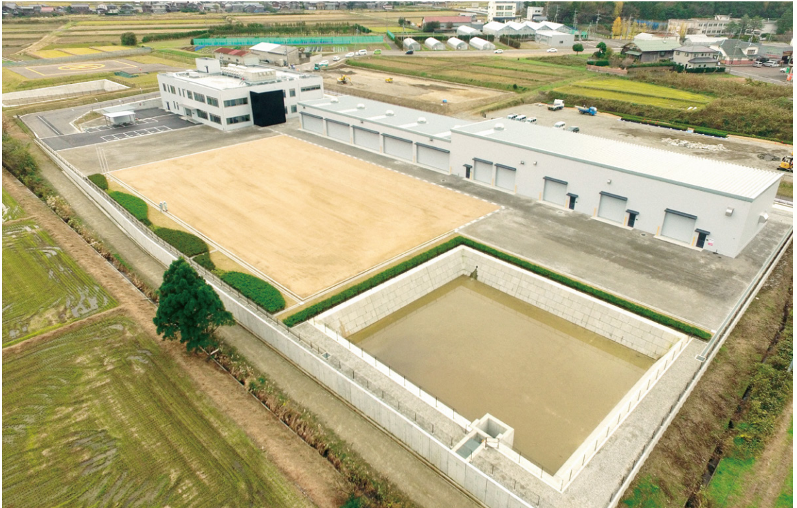
美浜原子力緊急事態支援センター 全景（無線ヘリコプターを使用して撮影）
