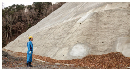
斜面にモルタルを吹き付けた防火帯
