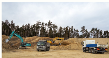
盛土材の供給を通じて女川町の復興にも貢献
