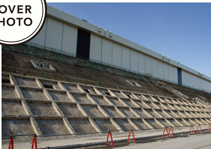
さらなる安全性向上へ防潮堤のかさ上げ工事が進められている
