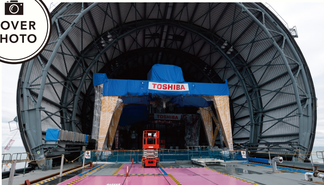
3号機オペレーティングフロア※1
