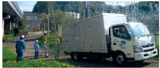
小樽変電所で現地確認を行う沖縄電力の応援部隊 提供:北海道電力
