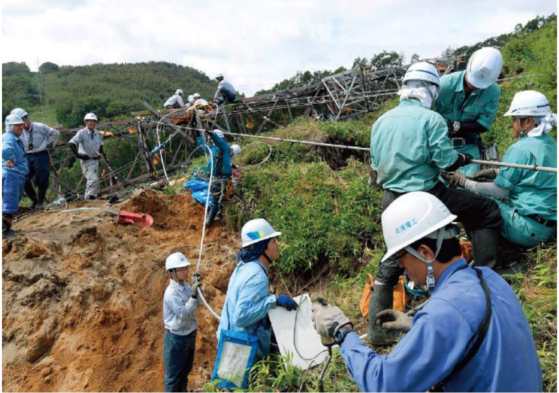
地滑りにより鉄塔が倒壊した現場での復旧工事(北海道むかわ町)
