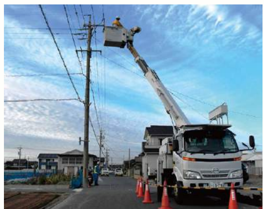
飛来物を除去する中部電力作業員
