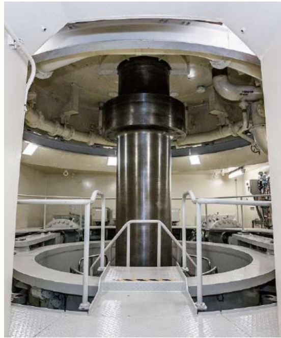
発電設備は2基。写真は2号機のポンプ水車室
