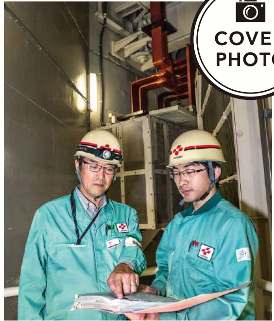
発電機室での点検風景
