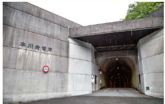
地下にある本川発電所への入り口
