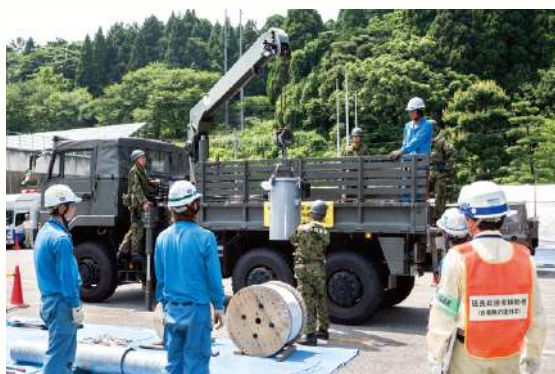
自衛隊車両による復旧用資機材の輸送訓練
