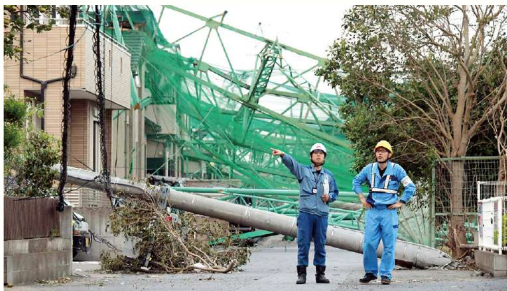
ゴルフ練習場のフェンスが倒壊し、住宅や配電設備が被害を受けた現場で状況を確認する
