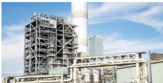
石炭ガス化複合発電設備
