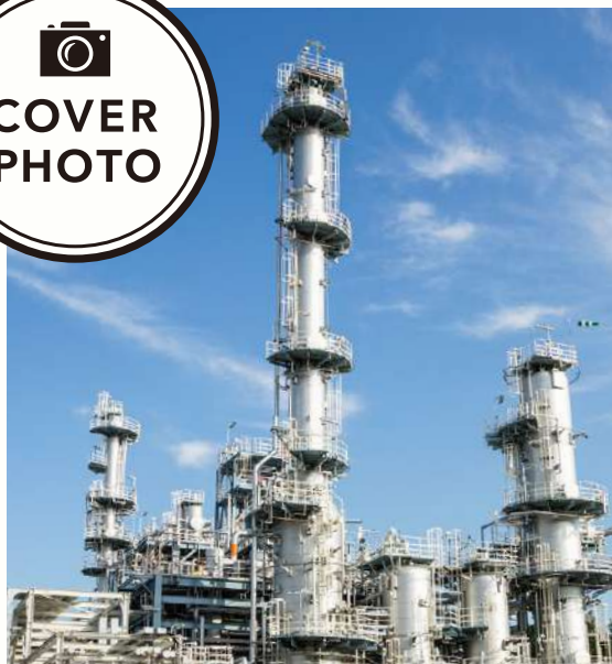
完成したばかりのCO 2 分離回収設備
