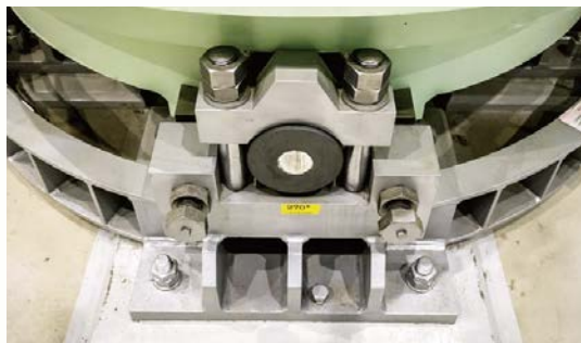
キャスク下の支持構造物には耐震補強を施した
