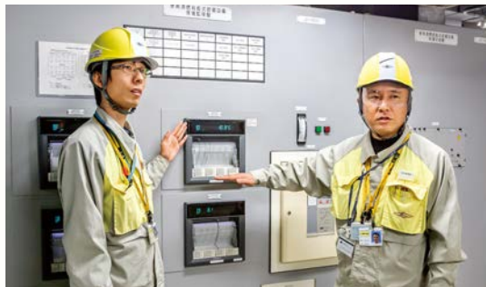
電気室では、温度・圧力・放射線量を監視
