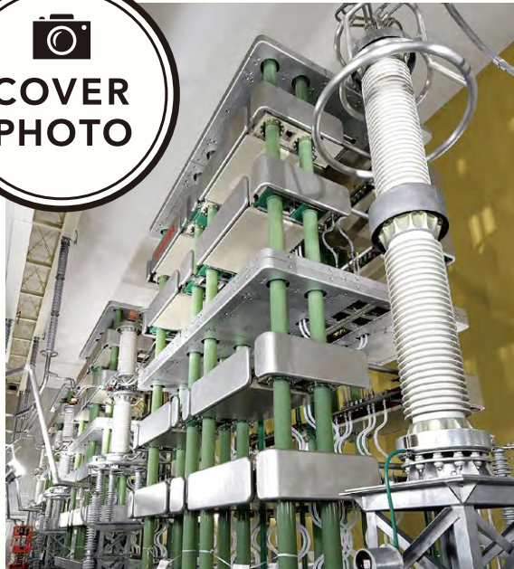
交流・直流の変換を行うサイリスタバルブ 提供：電気新聞
