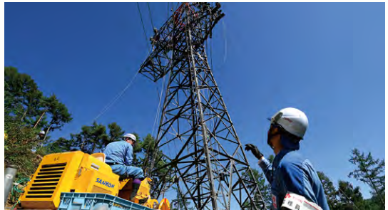
直流送電線の建設も進んでいる 提供：電気新聞
