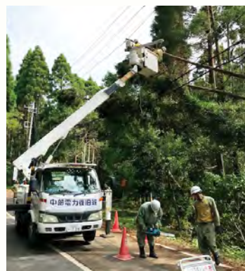
台風15号では全国の電力会社から応援が集結した 提供:中部電力
