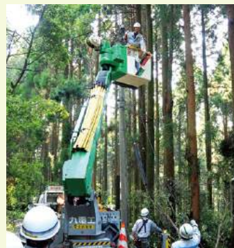
配電線復旧作業の様子 提供：電気新聞
