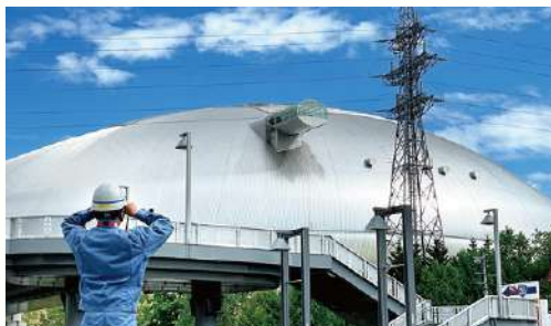
北海道電力ネットワークによる札幌ドームでの巡視の様子 提供：北海道電力
