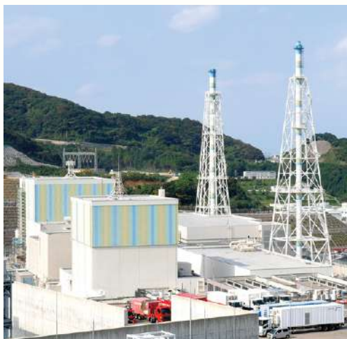
島根原子力発電所の外観。左奥が2号機 提供：電気新聞
