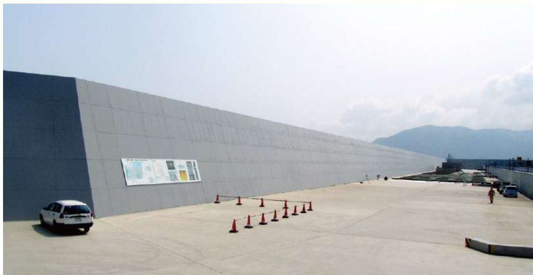
海拔15mの防波壁
