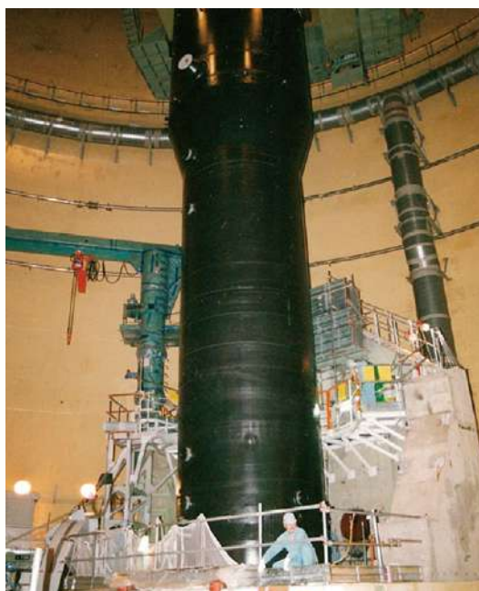
美浜3号機の蒸気発生器取り替え作業
