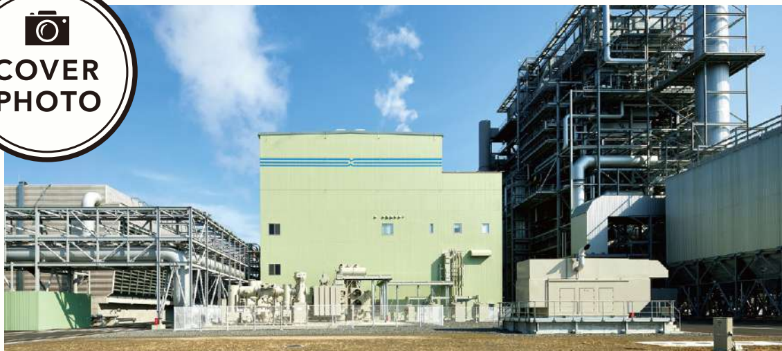
発電所の設備外観(右からボイラ、タービン建屋、冷却塔)
