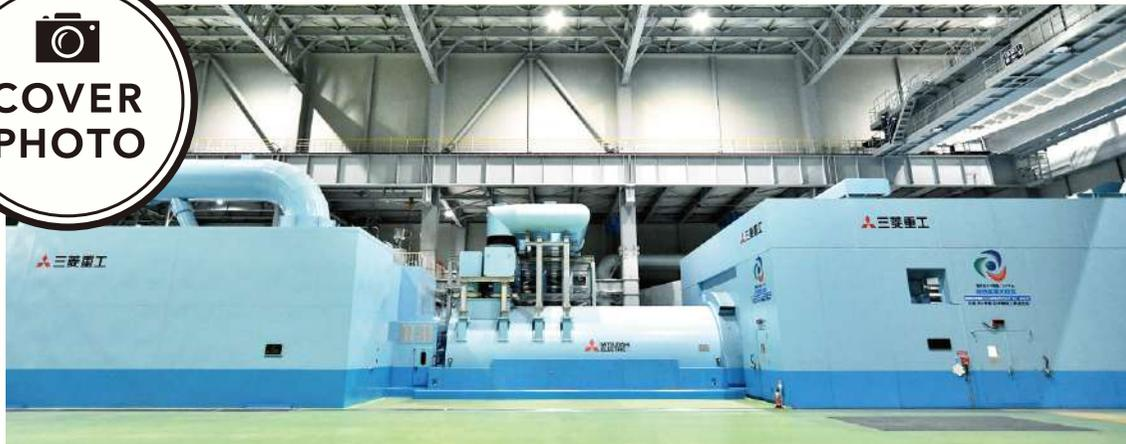
メーカーと長年にわたって共同開発した新型ガスタービン(左から蒸気タービン、発電機、ガスタービン)
